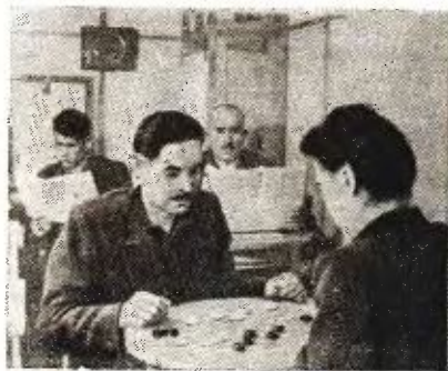
В комнате отдыха земснаряда «Сормовец-7» (строительство ирригационной сети зоны Главного Туркменского канала).
